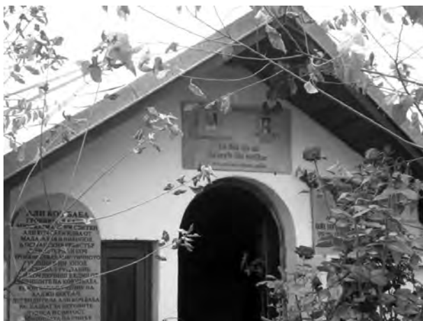
Завие и тюрбе на алианския светец Али Коч баба в северните покрайнини на Никопол Източник: Личен архив.
